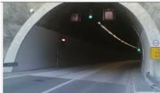
Tunel sa dvosmernim saobraćajem (jednom tunelskom cevi)
